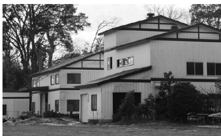
一次加工工場・原料倉庫 ・農業倉庫
