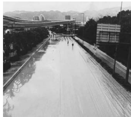
【参考1】震災後の東部市場とポートアイランドの液状化現象 (出典：神戸市HP／阪神・淡路大震災「1.17の記録」)
