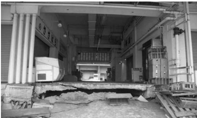
【参考1】震災後の東部市場とポートアイランドの液状化現象 (出典：神戸市HP／阪神・淡路大震災「1.17の記録」)
