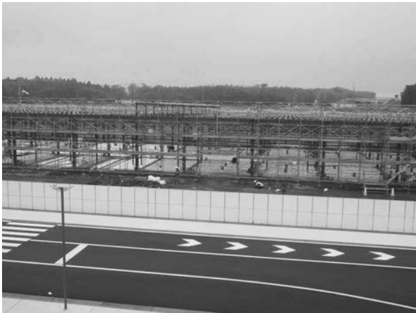
建設中の関連食品棟
